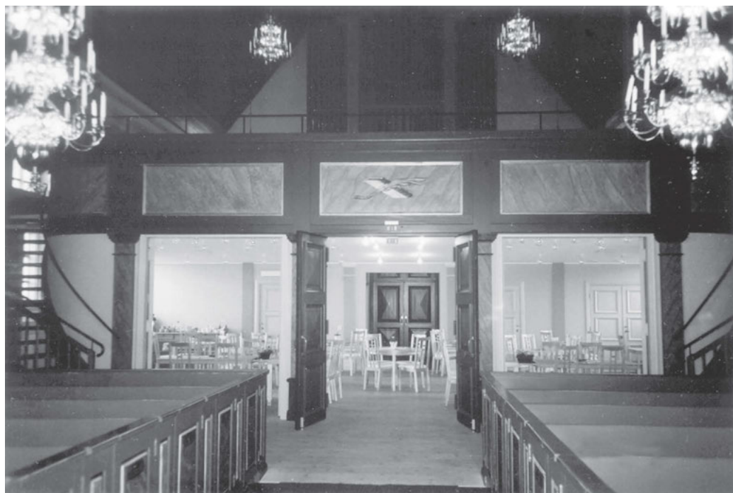
FIGUR 7. Lima kyrka i Dalarna. Den väldiga nyklassicistiska kyrkan byggdes 1853–56 efter ritningar av Albert Törnqvist. År 2005 genomfördes en omfattande ombyggnad, läktaren utvidgades och underbyggdes med en stor lokal för samling och servering efter ritningar av Gösta Eriksson, E-Arkitekter, Stockholm. FOTO: Ingrid Sjöström.
